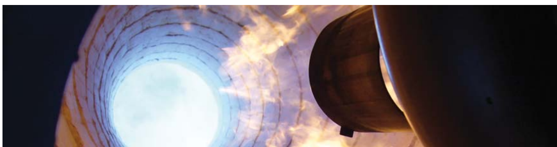
Wzrost do mobilnej komory spalania. Elastyczne rozwiązanie w zakresie obróbki spalin po otwarciu fermentatora
