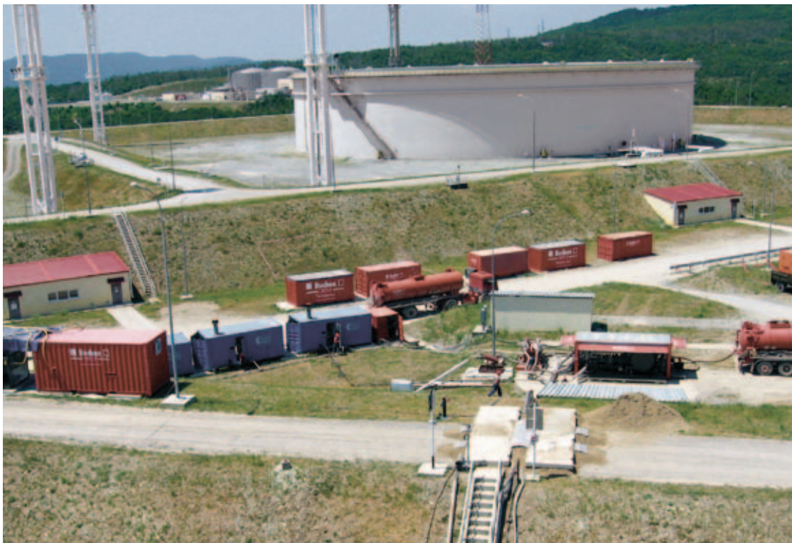
Automatisierte Buchen-Tankreinigungsanlage am zu reinigenden Schwimmdachtank im Tanklager von Novorossiysk
