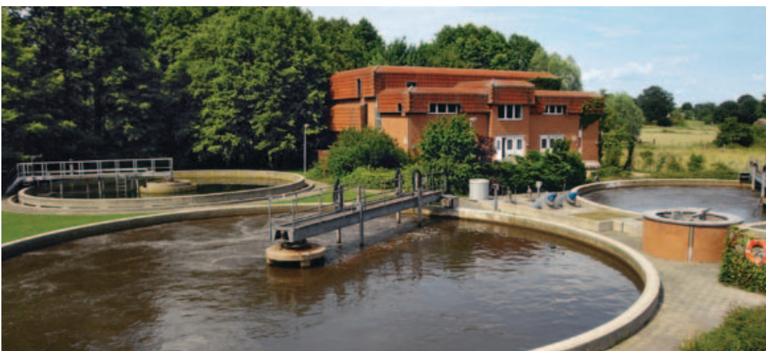
Die moderne Trockenfiltration sichert eine hohe Reinigungsqualität der Abwässer
